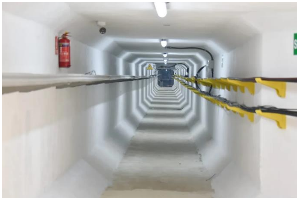
Túnel de servicio en la avenida Benito Monción, Centro Histórico de Santiago.
